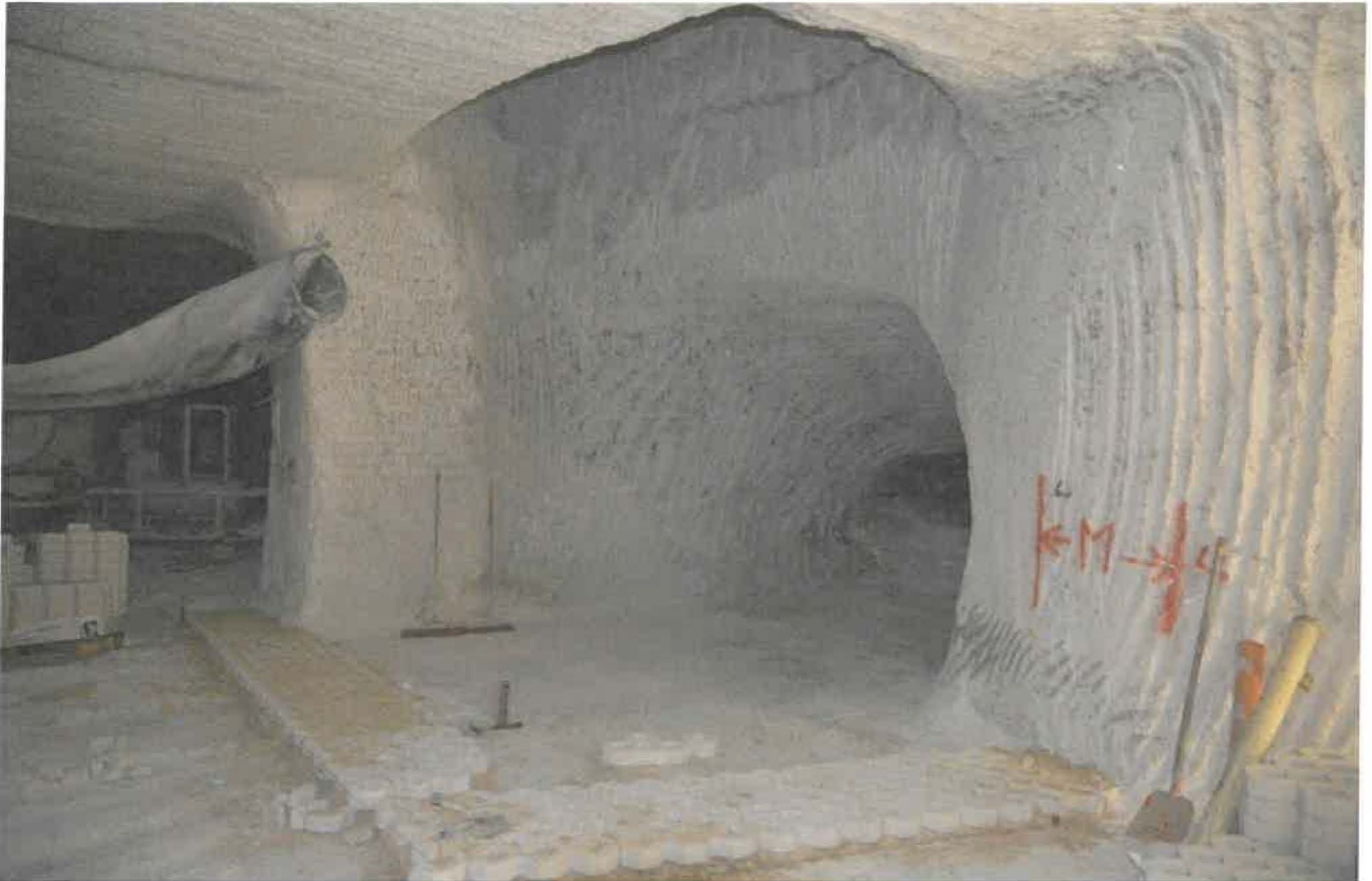
Abbildung 1: Arbeitsort auf der 725-m-Sohle
